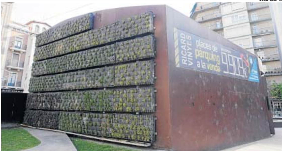
Imatge del 'jardí vertical', ubicat a la paret d'un dels accessos al pàrquing de Ricard Viñes.
