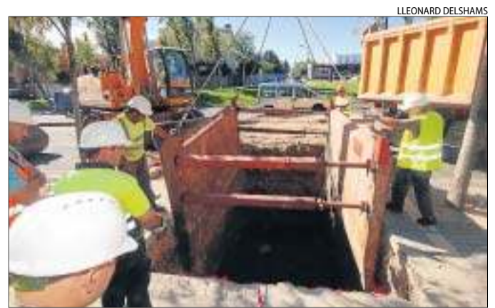
Una màquina excavant ahir la gran rasa a Rovira Roure.
