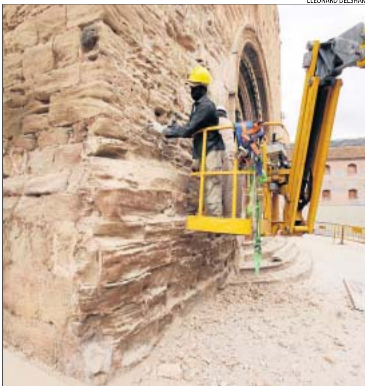
Dos operaris treballant ahir a la façana de l'església.
