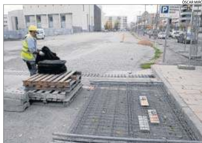
El tram de l'avinguda Estudi General que serà urbanitzat.
